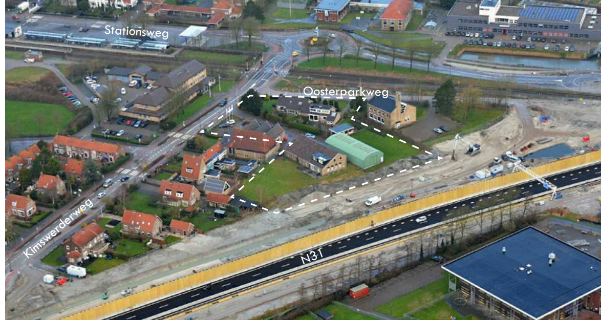
Accountants kantoor in voormalige kerk
