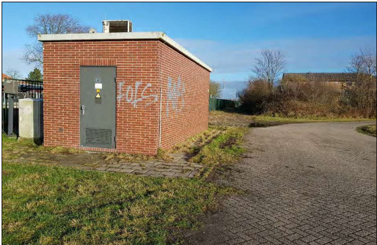
Figuur 2.3. Het transformatorhuisje in het plangebied wordt niet geschikt geacht voor verblijfplaatsen van o.a. vleermuizen.
