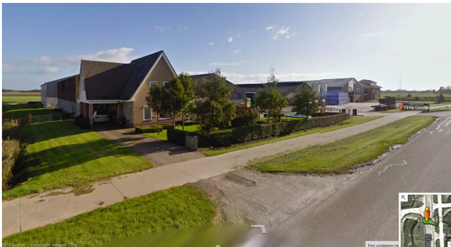
Figuur Aanzicht erf vanuit het noorden (Bron: Google Maps, streetview 2015)
