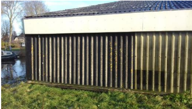
Figuur 6: gevelplaten Zevenhuizen nr. 3
