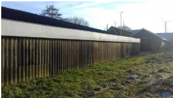
Figuur 7: Overzichtsfoto bebouwing
