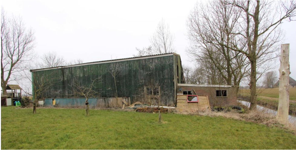
Figuur 3. Aanzicht bestaande schuur achterop het erf
