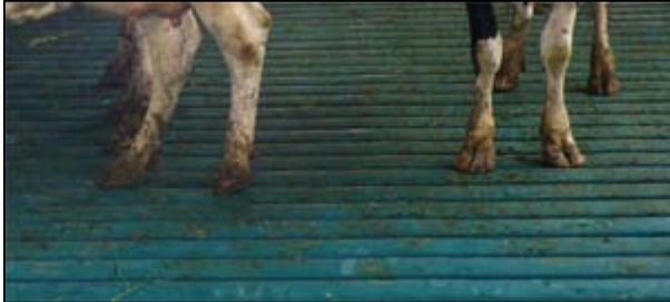
Figuur 67. Groene Vlag Roostervloer: emissiearm stalsysteem voor melkveehouderijen
