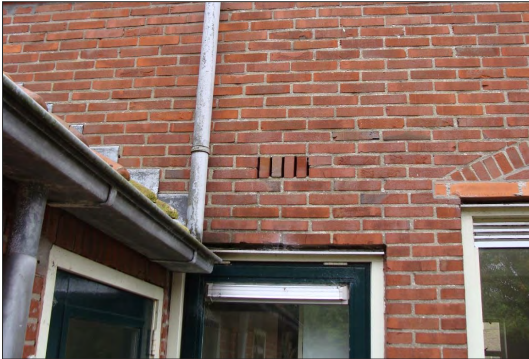
Figuur 11. Bij sommige woningen is een rij open stoevoegen aanwezig boven de keukendeur.
