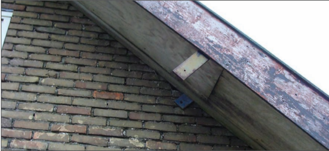
Figuur 12. Beschadigd voegwerk op de zuidgevel van de oostelijke 'woning'.
