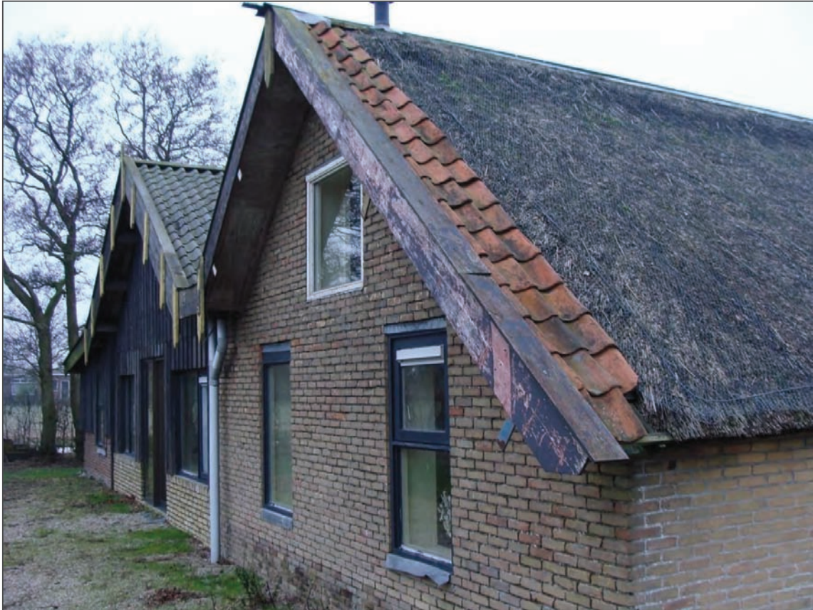
Figuur 5. Beide 'woningen' aan de achterzijde van het perceel.
