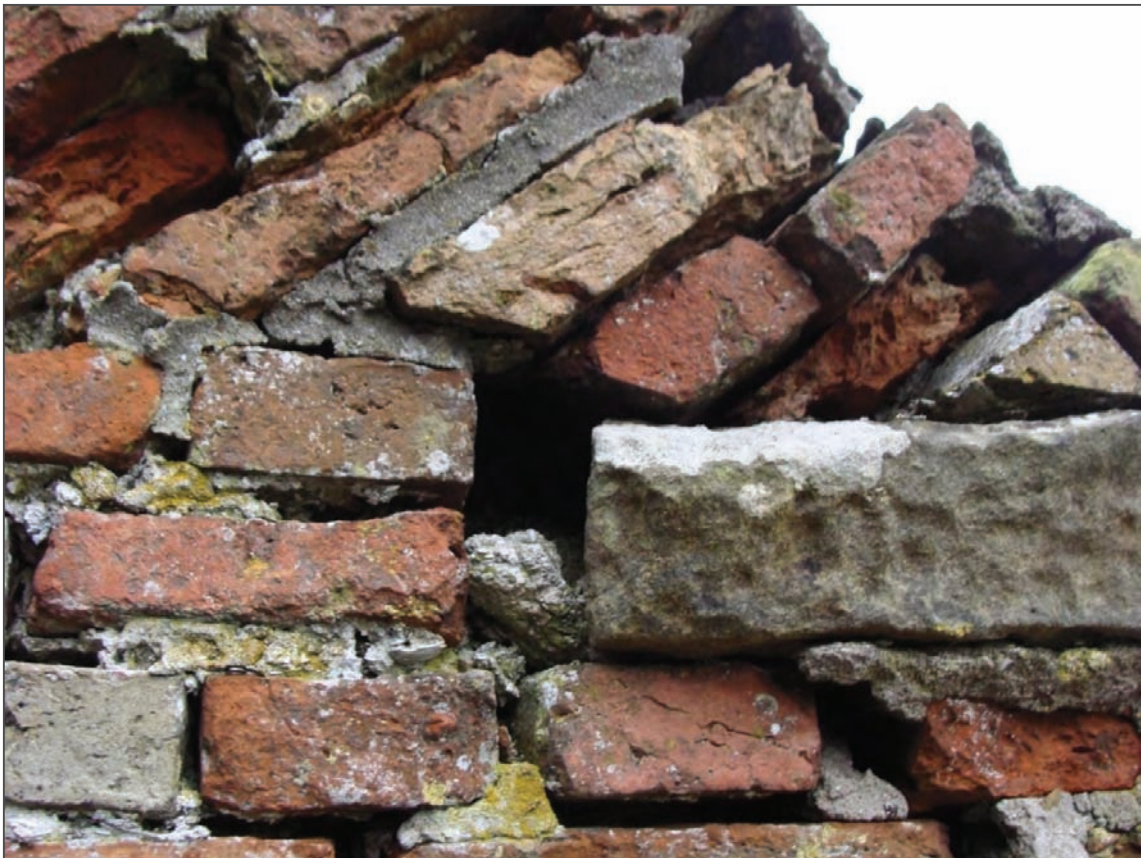
Figuur 9. Zwaar beschadigd voegwerk van de zuidoost muur van de schuur.
