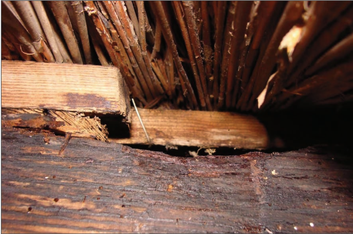
Figuur 8. Aangetast houtwerk geeft vlemuizen toegang tot de schuur.
