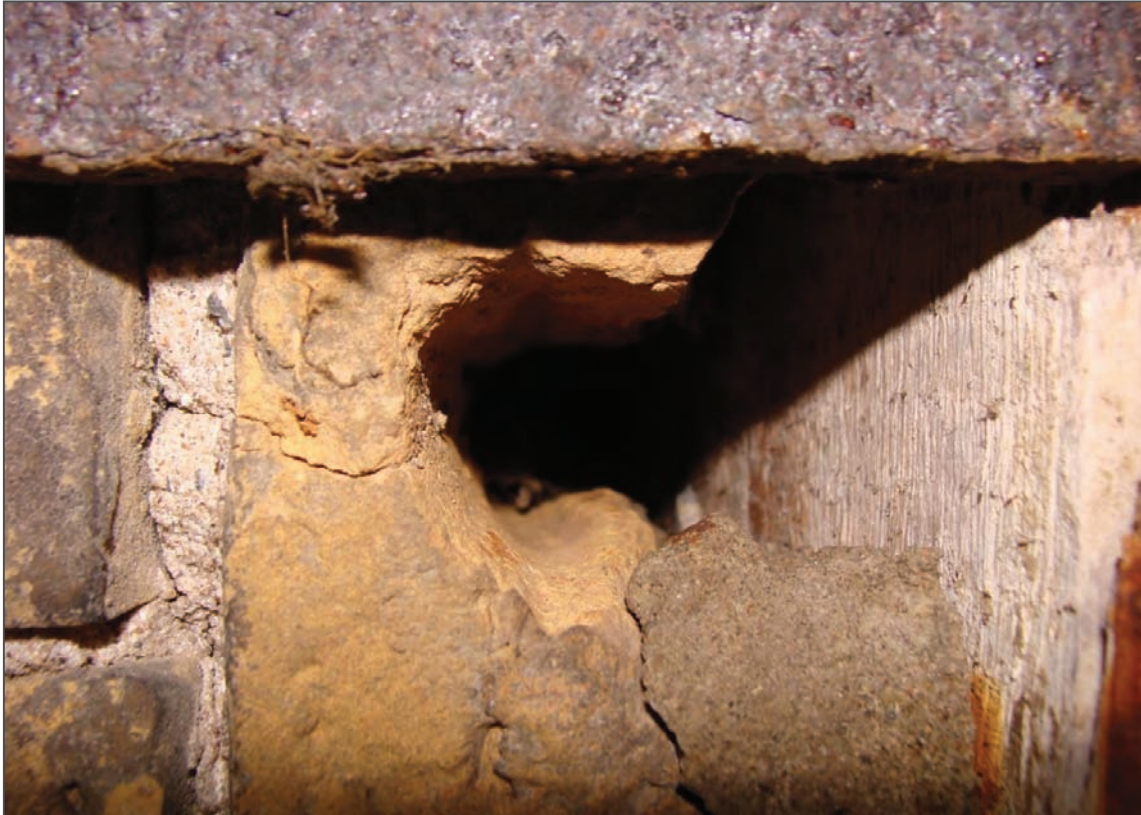
Figuur 11. Via kleine openingen in de muur is de luchtspouw van de oostelijke 'woning' aan de achterzijde van de bebouwing toegankelijk.
