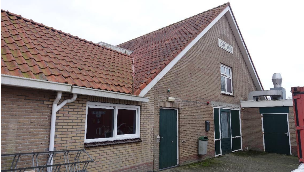
Foto 5. Blik op de noordelijke gevel van het hoofdgebouw en de aansluiting tussen de twee delen van de L-vorm. Foto Johan Krol. 24-11-2021.
