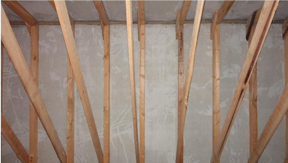
Foto 3. Blik in de zolderkap van het kleine deel van het L-vormige gebouw. De kap (zie foto 2 groene geveltop) is niet toegankelijk en wordt niet gebruikt en de dakplaten zijn overal sluitend waardoor er geen toegang is voor dieren. Foto Johan Krol. 24-11-2021.
