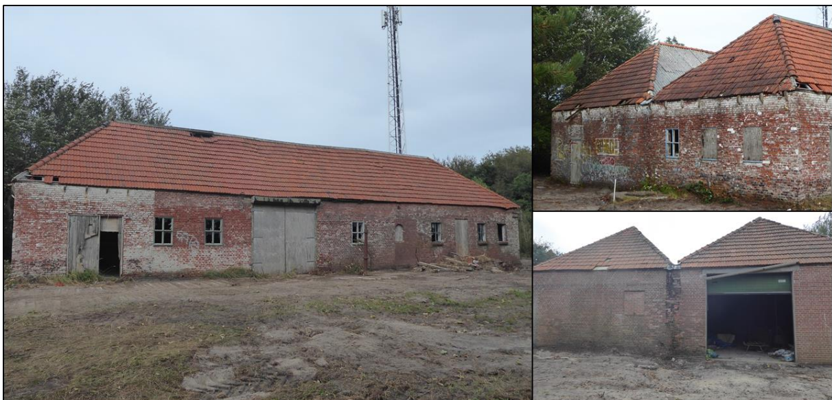
Figuur 2.2. Impressie gebouw voormalige discotheek.
