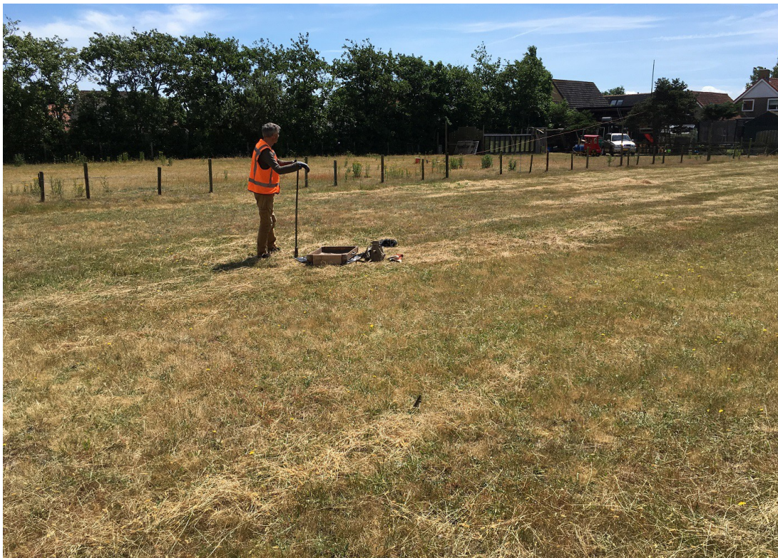
Figuur 7: Buren, Paasduinweg: Foto gemaakt richting het zuidoosten, tijdens het uitvoeren van boring 5.
