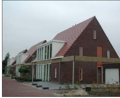
Bouw van starterswoningen
