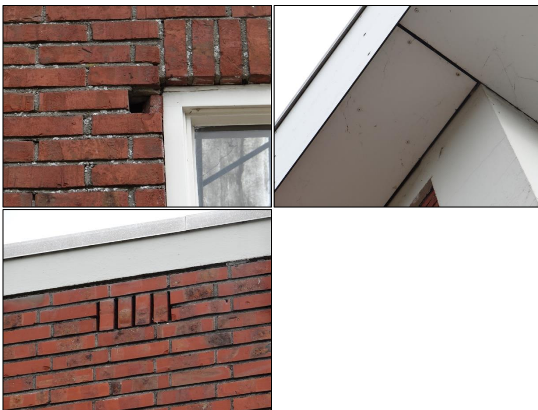
Foto 9 t/m 11. Diverse openingen in het fabriekspand die kunnen leiden naar vleermuisverblijfplaatsen
