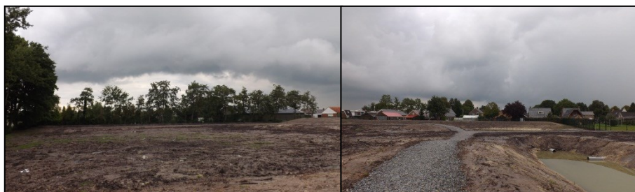
Figuur 6. Plangebied richting het noordwesten (links) en oosten (rechts)
