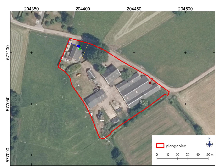
Figuur 3. Harkema, Nijewei 89: Luchtfoto van het plangebied. Het plangebied is rood omlijnd. Er liggen kabels en leidingen in het plangebied (KLIC-melding: 22G170587).
