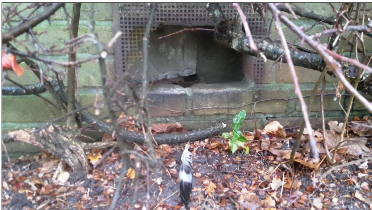
Figuur 3.2. Locatie waar steenmarter toegang tot het gebouw zou kunnen vinden.
