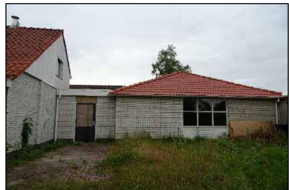
Afbeelding 2.3. Westzijde lagere deel met dakpannen.
