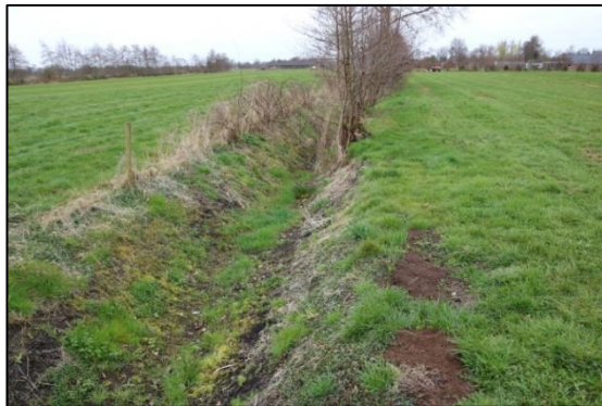
Afbeelding 2.2. Drooggevallen watergang aan de zuidzijde van het plangebied.
