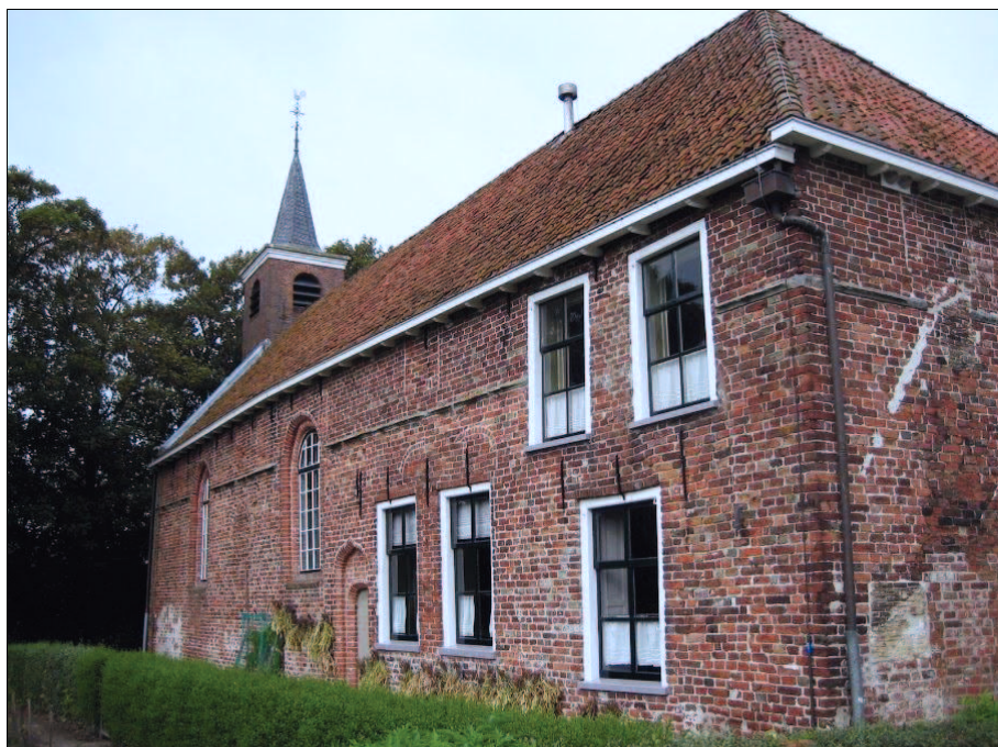
Figuur 3. Rijksmonumentale kerk aan De Poorthoek 1
