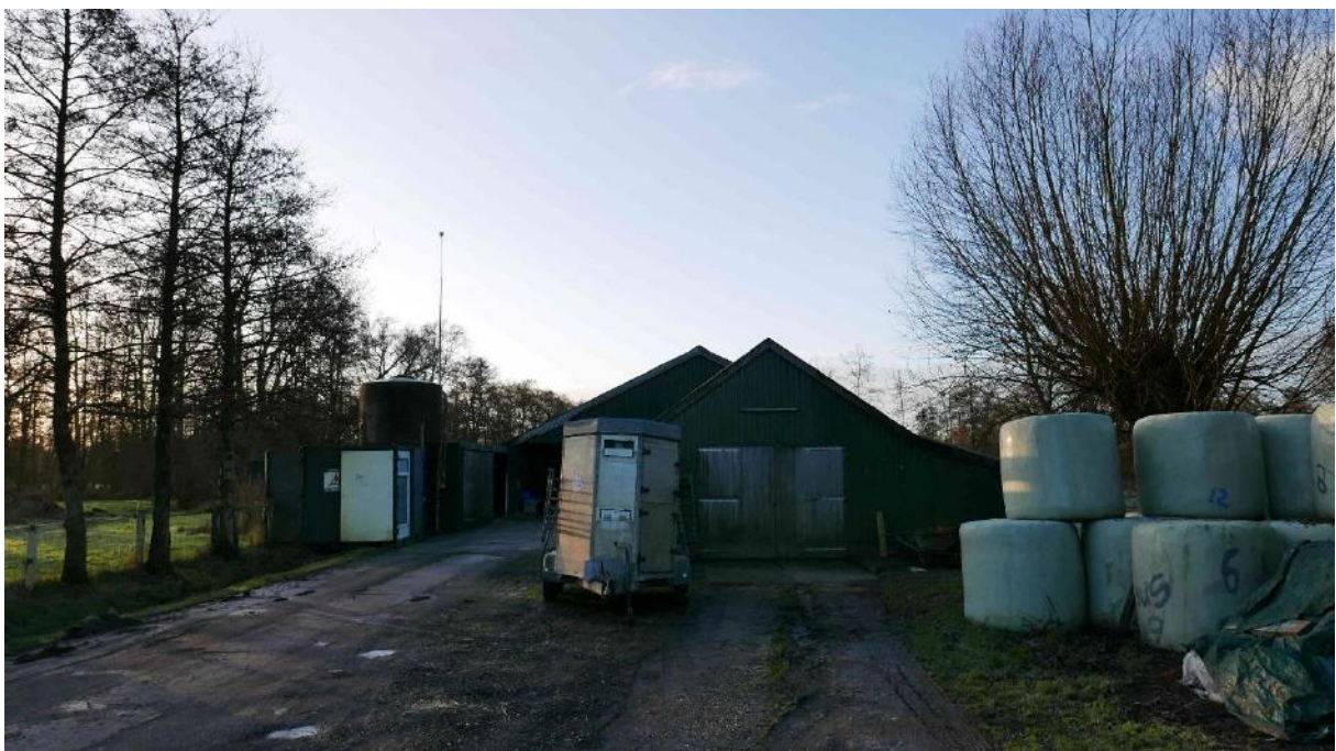
Vooraanzicht schuur aan de Oude Dijk 1a. Foto richting zuiden.
