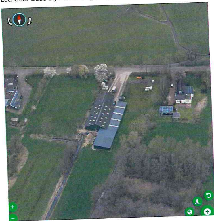
Bestaande stallen Oude Dijk 1a (bron: Nedbrowser)
