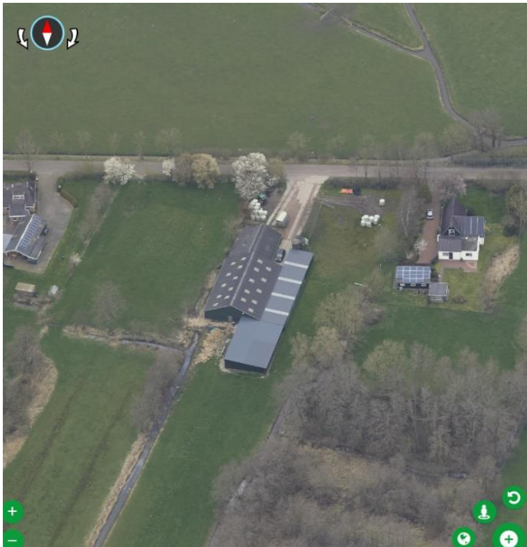
Bestaande stallen Oude Dijk 1a (bron: Nedbrowser)
