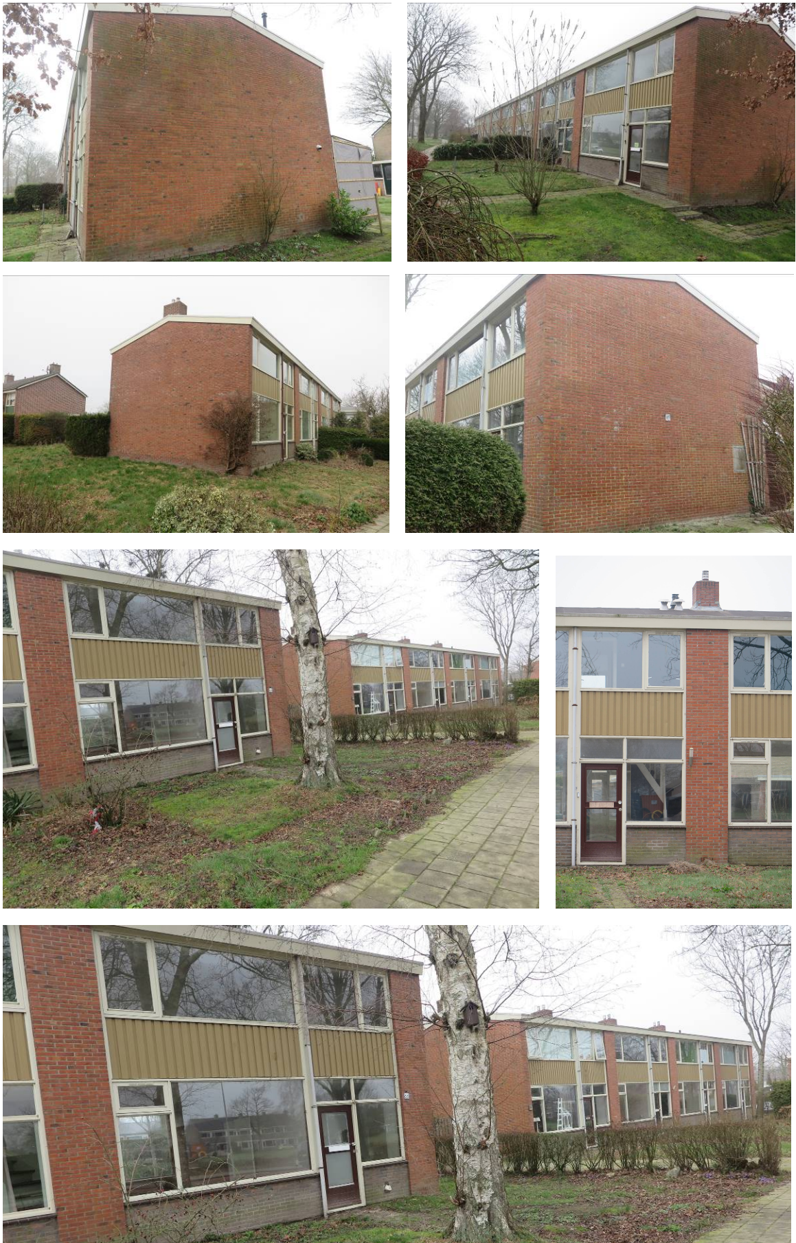
Figuur 2. Foto-impresie van het plangebied aan de Halbertsmastraat te Buitenpost (te slopen).
