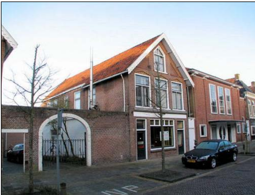
Figuur 3. Bestaande voorgevel
