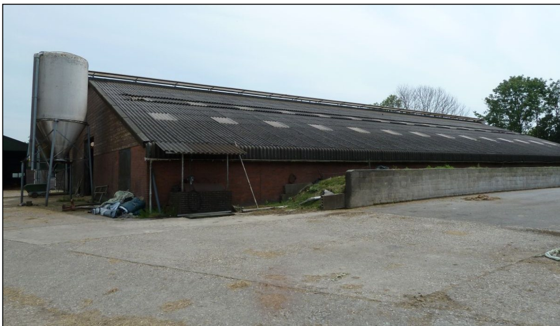
Figuur 7. Situatie plangebied op 4 juli 2012, ligboxenstal en naastgelegen sleuvsilo. Rechts deel van de houtsingel.
