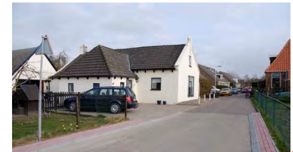
Gemetselde topgevel aan de Buorren
