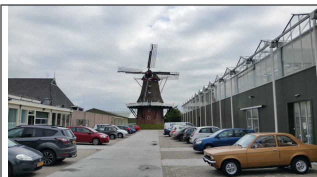
De molen gezien vanuit het westen. Links de vleugel waar op termijn een nieuwe bouwlaag op aangebracht dient te komen. Rechts het kassencomplex dat omwille van het zicht op de molen niet verder is doorgetrokken.
