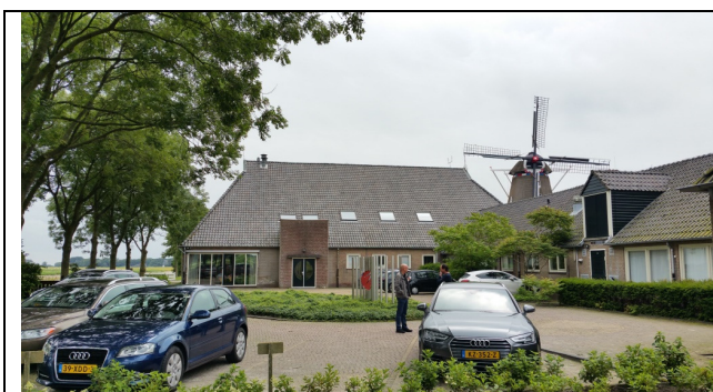
Molen Ropta gezien vanuit het westnoordwesten met links de hoge schuur van de voormalige boerderij. Het is duidelijk te zien dat deze te hoog is en ver boven de stellinghoogte van de molen uitsteekt.
