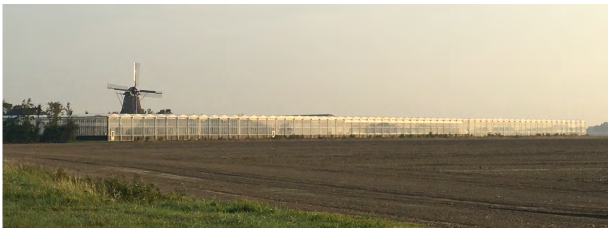
Zicht op het erf vanuit het zuiden (Bron: BV, 2016)
