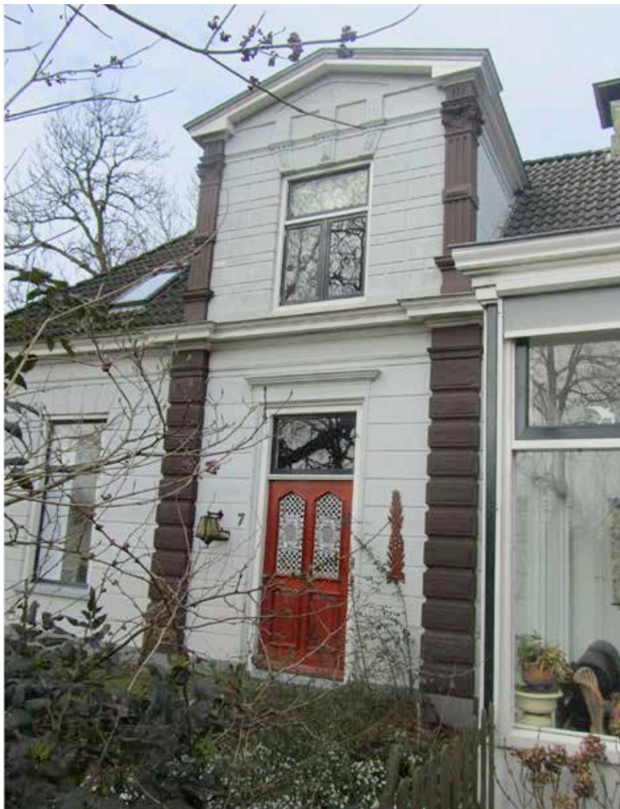
foto zuidgevel voorhuis
