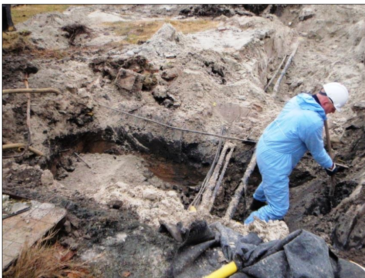
Afbeelding 5. Foto van de start van de sanering. Op de achtergrond ligt de locatie van een verwijderde tank. De vele leidingen, waaronder een gasleiding, zijn duidelijk zichtbaar
