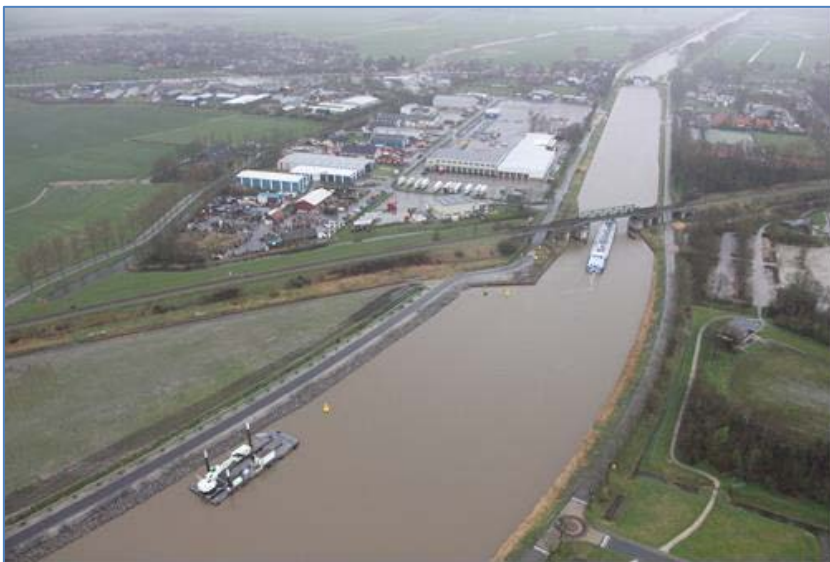
Figuur 8. Huidige bochtverruiming en huidige spoorbrug (Provincie Groningen, Voordracht Gedeputeerde Staten, 03-06-14)
