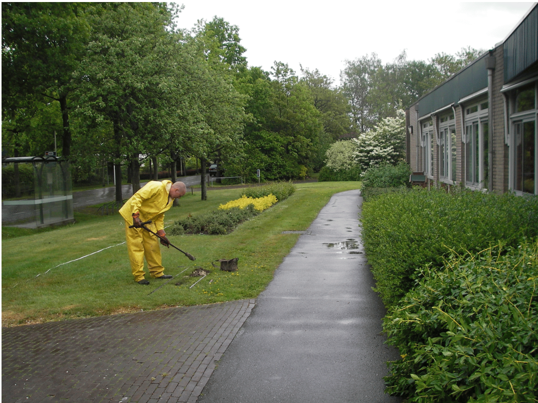
Figuur 2: Zuidhorn: Zonnehuis. Op de foto wordt boring 17 uitgevoerd. Rechts is de bebouwing van het verpleeghuis zichtbaar. De foto is gemaakt in noordoostelijke richting.
