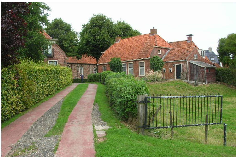
Figuur 6. Historische structuur, zuidzijde wierde
