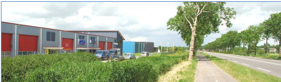
Figuur 4. Ligging bedrijventerrein aan Rijksweg (N355)
