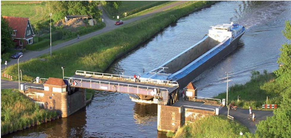
Figuur 2. Huidige brug (provincie Groningen)
