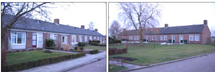
Figuur 2. Bestaande situatie voor- en achtergevel seniorenwoningen Warten
