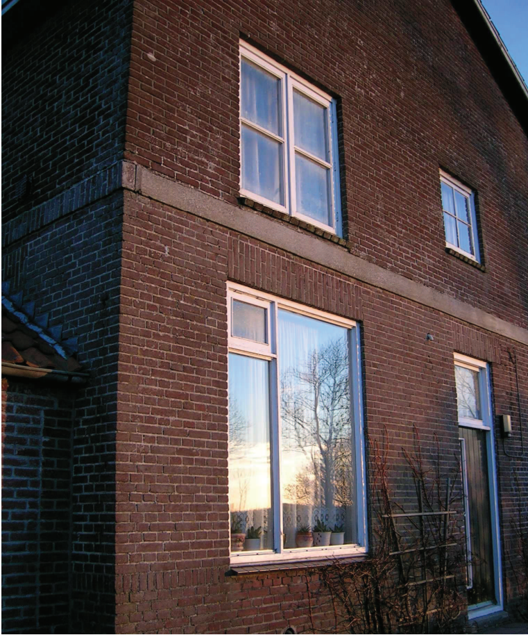
Zijgevel (West); kozijn slaapkamer (onder) en kozijn slaapkamer 5 (linksboven)
