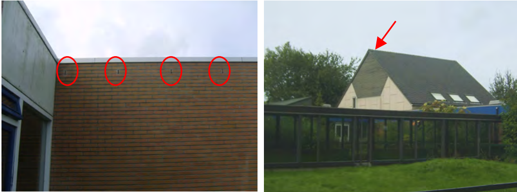
Figuur 4. Mogelijke invliegopeningen (verblijfplaatsen) van vleermuizen. Links spouwgapen, rechts mist een dakpan.
