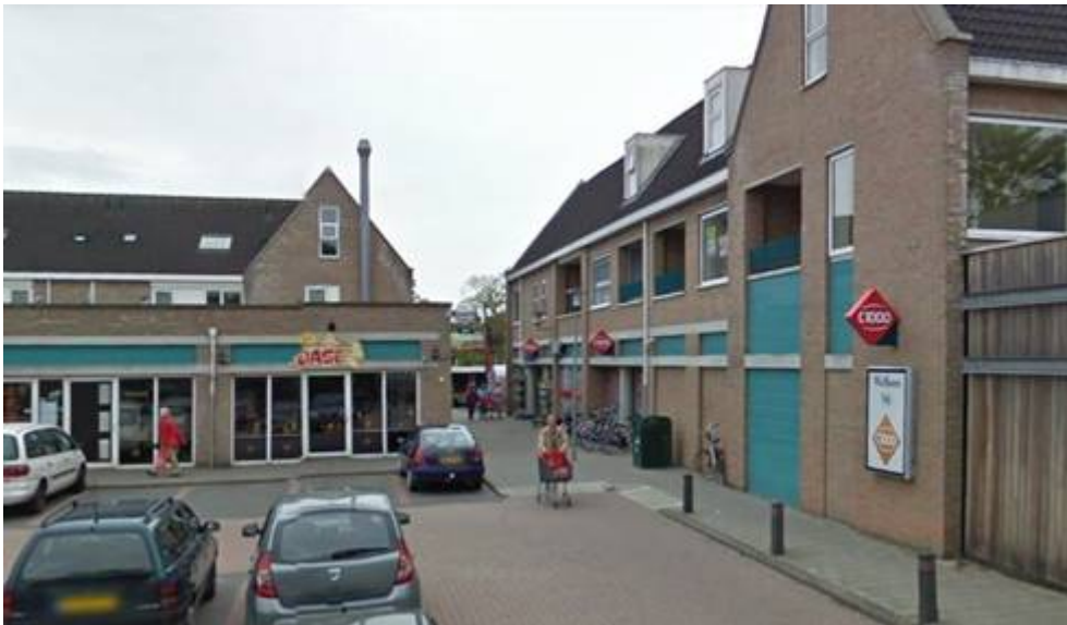
Figuur 8. Passage tussen oostelijk en westelijk blok (bron: Google Earth)
