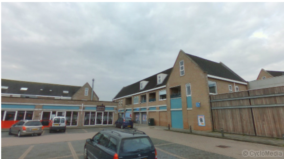
Figuur 8. Passage tussen oostelijk en westelijk blok (bron: Google Earth)
