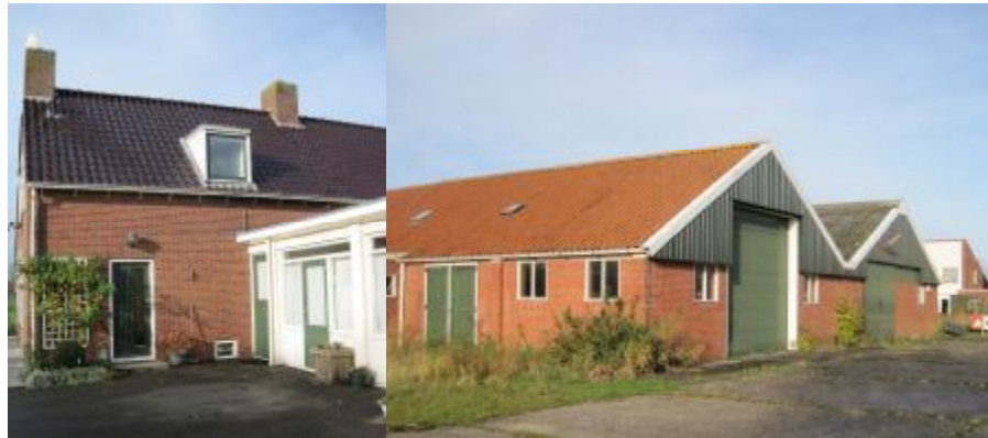
Foto 1: woning en aanbouw
