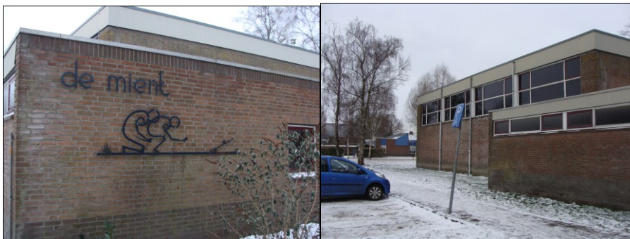
Overzicht plangebied met gymzaal
