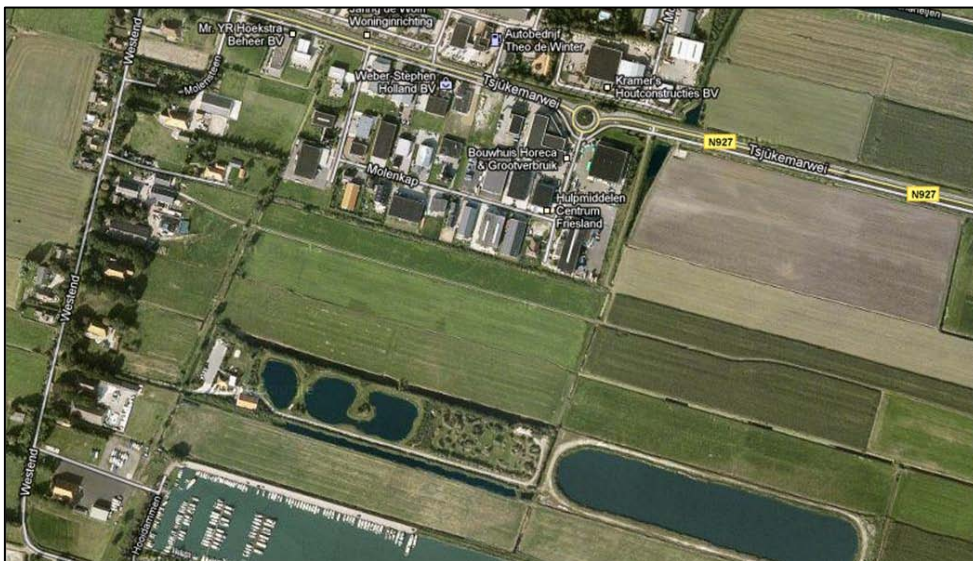
Figuur 2. Luchtfoto huidige situatie
