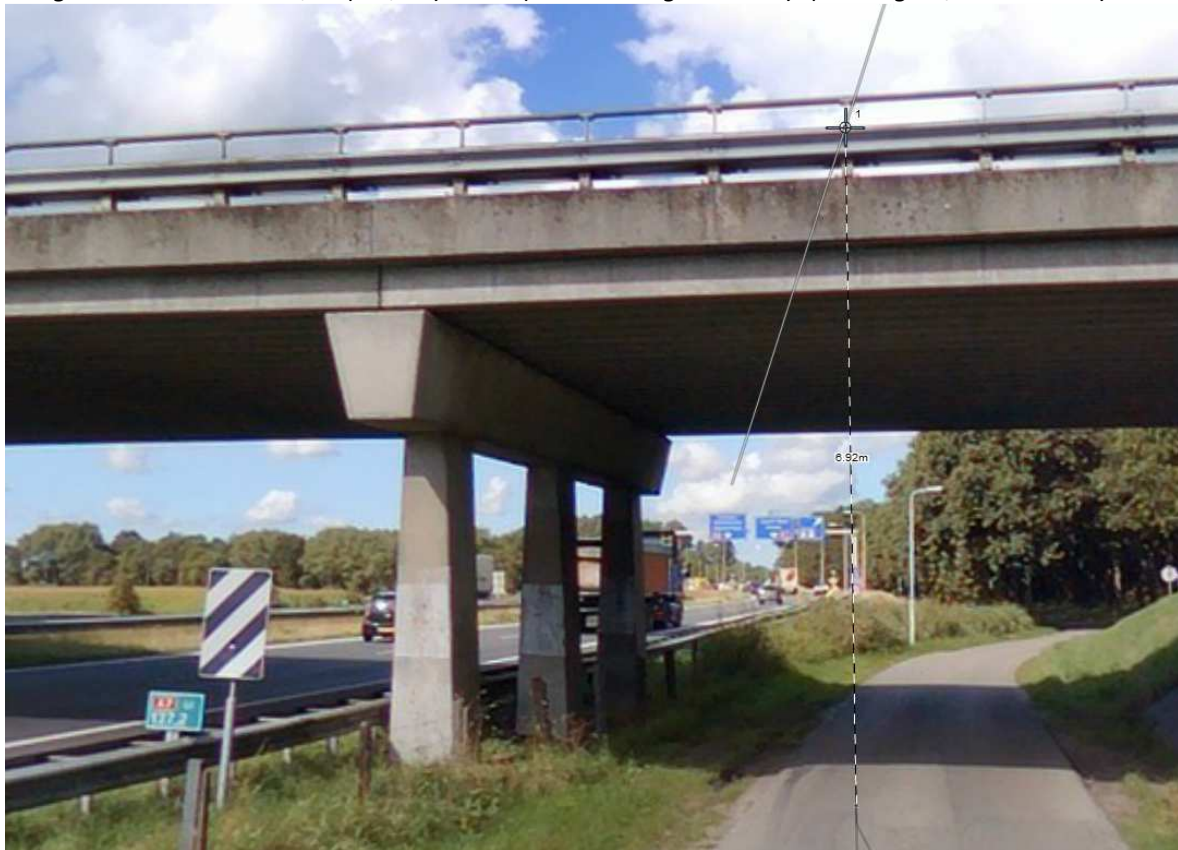
Hoogte van het viaduct 6,92 (= 7,00) meter (bovenkant geleiderail) (richting A7/Heerenveen)
