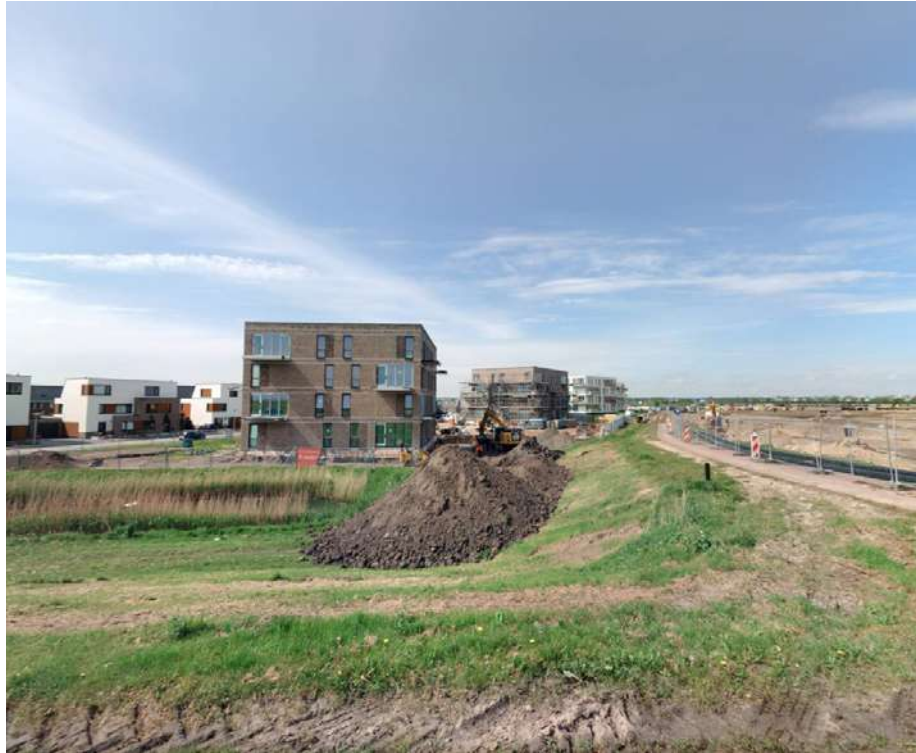
Zicht op 4-laags appartementengebouw aangrenzend woongebied Molenbuurt
