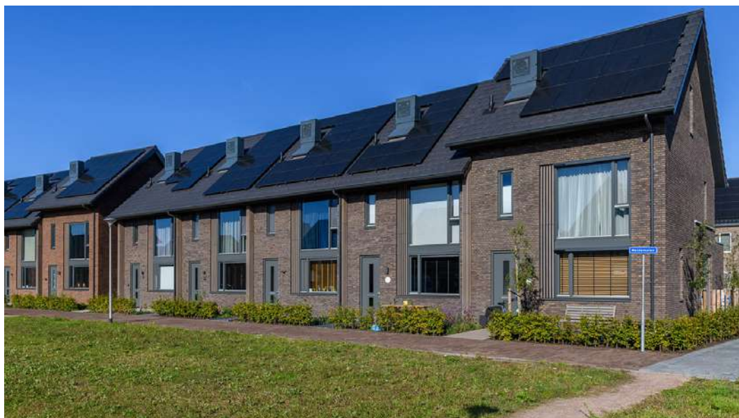
Grondgebonden woningen aan het park
