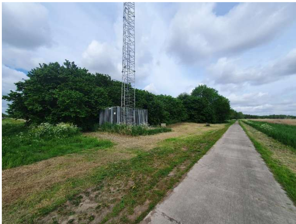
Figuur 2.6 Impressie van de groenstrook die langs de Wulptocht ligt. In deze groenstrook komen mogelijk enkele openingen van ongeveer 20 meter.
