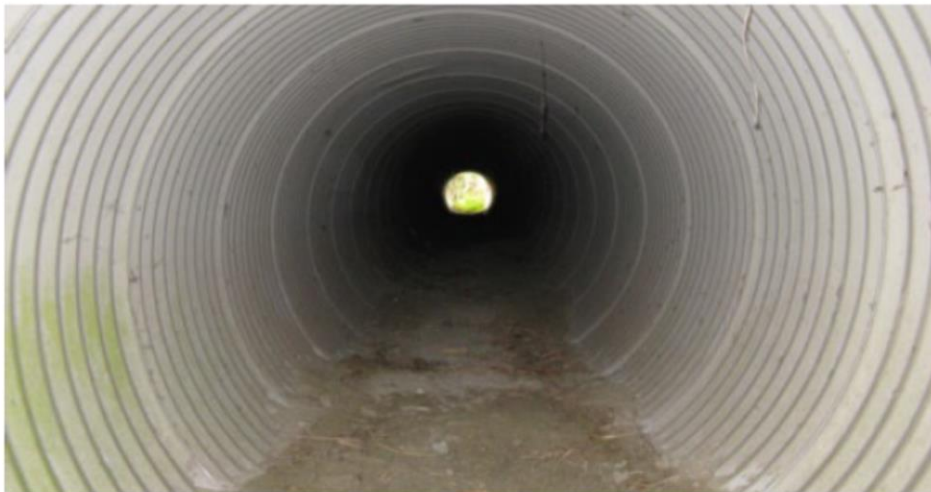
Figuur 8.68 Ronde faunapassage van gegolfde kunststof.
