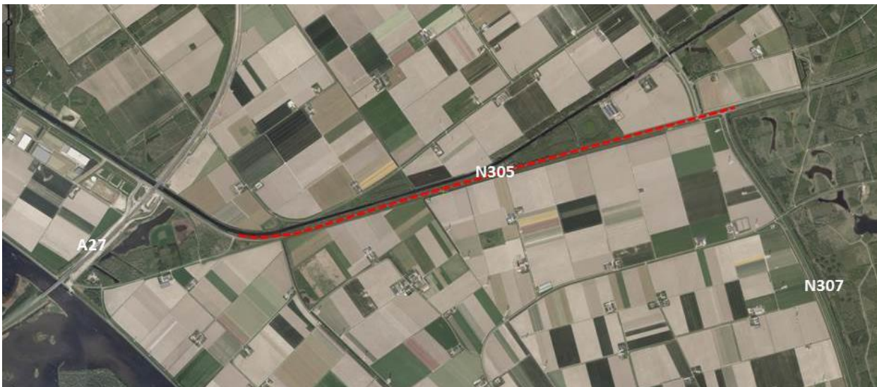
Figuur 3-1: Impressie projectgebied N305 fase 3 (bron luchtfoto 2015 Cyclomedia globetrotter)
