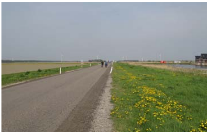
De Ossenkampweg (huidige situatie)
