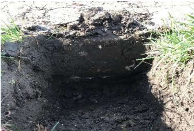
Figuur 7 fundering onder betonpad, 18 maart 2020
