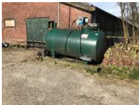
Figuur 22 brandstoftank asbestverdacht dak kleine schuur
