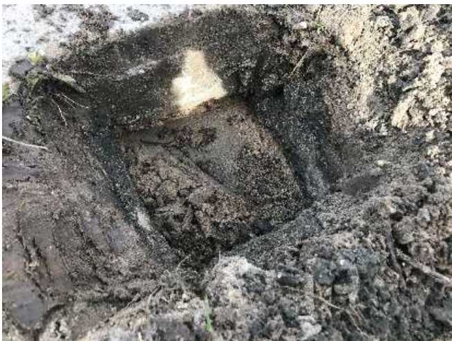
Figuur 9 fundering onder betonpad, 18 maart 2020
