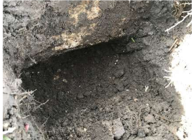
Figuur 8 fundering onder betonpad, 18 maart 2020
